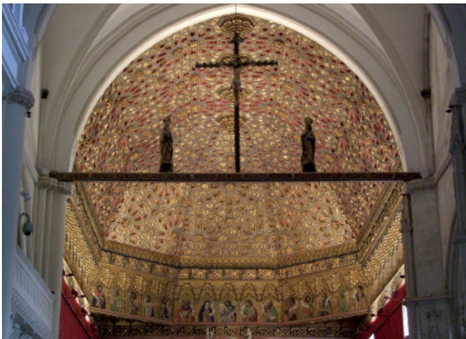
Armadura de la iglesia. Monasterio de Santa Clara, Tordesillas.
